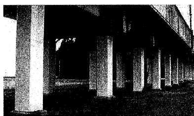
鋼板巻きによる高架橋の耐震対策
