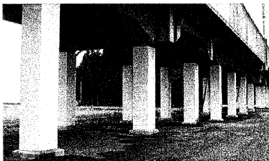
鋼板巻きによる高架橋の耐震対策
