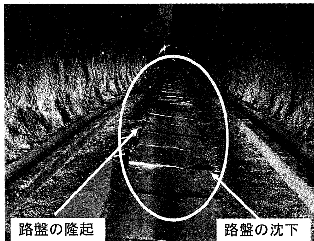
トンネル（先進導坑）の変状
