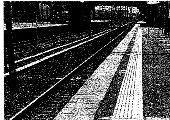
内方線付き点状ブロック
