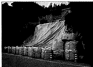
避難路を保全する土留工・排水工
