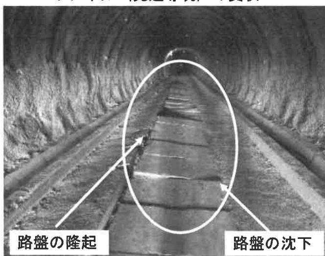
トンネル（先進導坑）の変状
