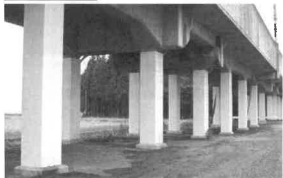
鋼板巻きによる高架橋の耐震補強
