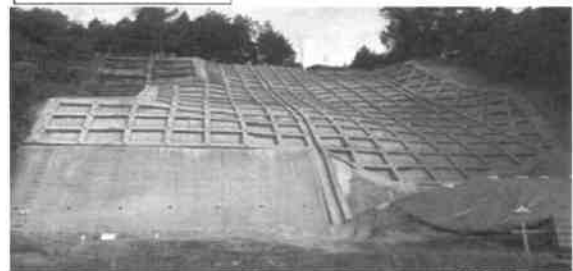
コンクリート枠による斜面の補強
