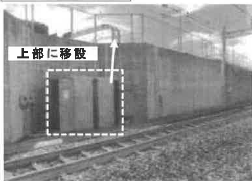
信号・通信設備の移設
