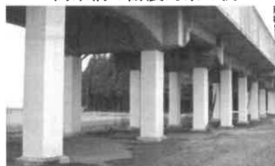
鋼板巻きによる 高架橋の耐震補強
