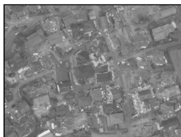
益城町における住宅・宅地の被害
