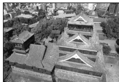
熊本城天守閣の被害
