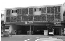
共同荷捌き施設
