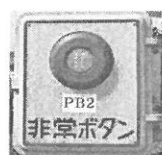
(非常押しボタンの例)
