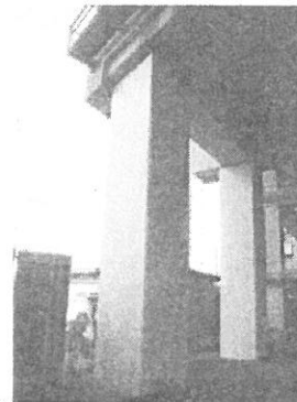
鋼板巻きによる高架橋の補強
