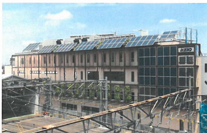
高幡不動乗務区・施設管理所 外観
