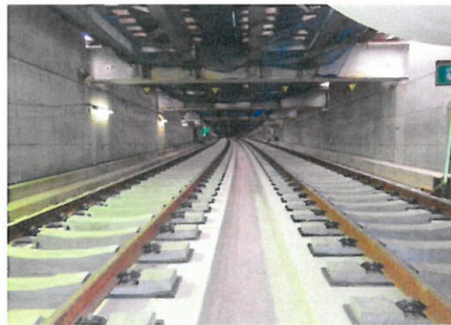
大師線連続立体交差事業（第1期）
