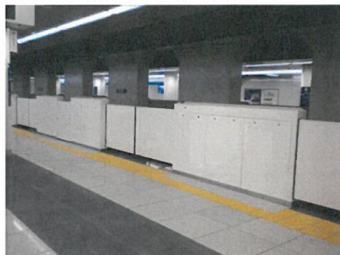
ホームドア（羽田空港国際線ターミナル駅）
