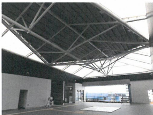
鉄道駅総合改善事業（金沢八景駅・新駅舎）
