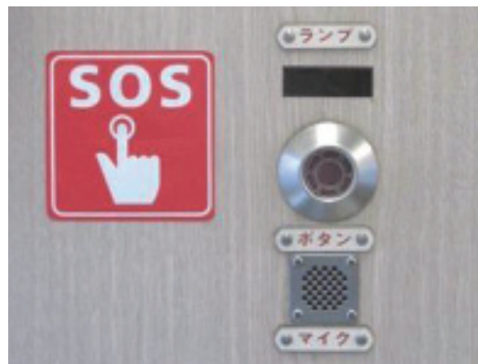
SOSステッカーと非常用通報通報装置
