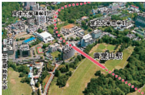
亀山トンネル周辺
