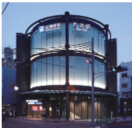
九条駅西出入口
