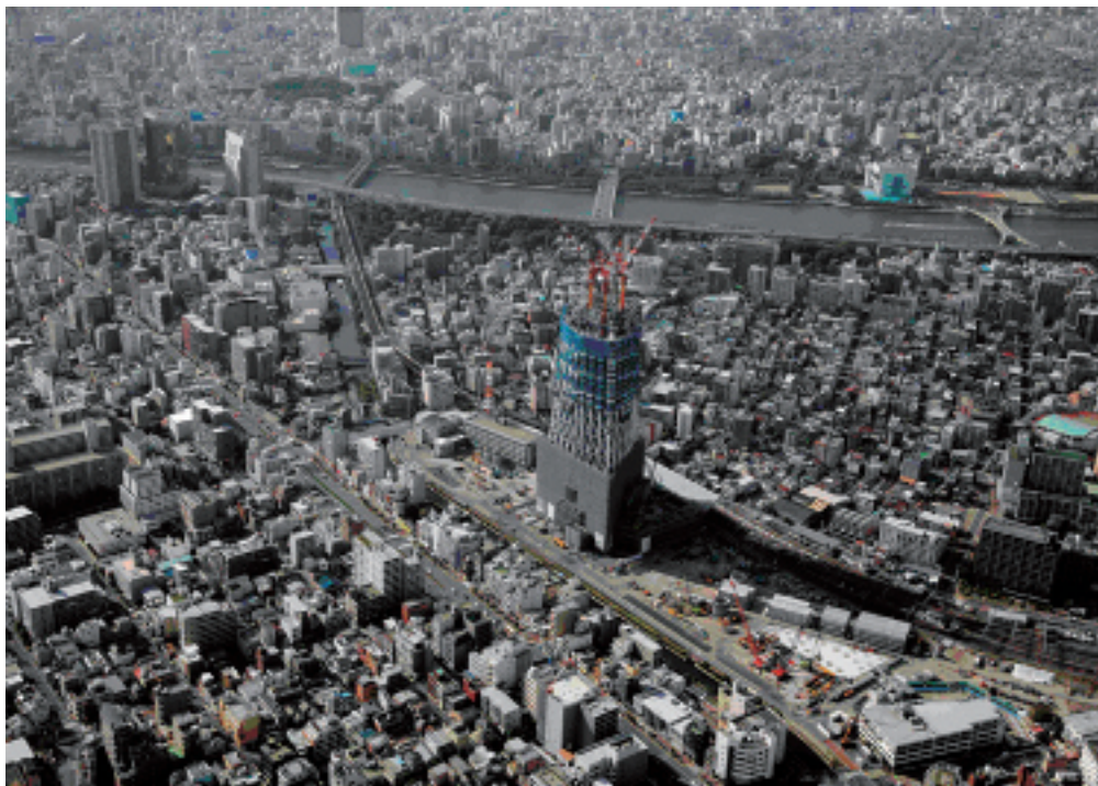
写真1 工事進捗状況（平成21年9月30日（株大林組提供）
