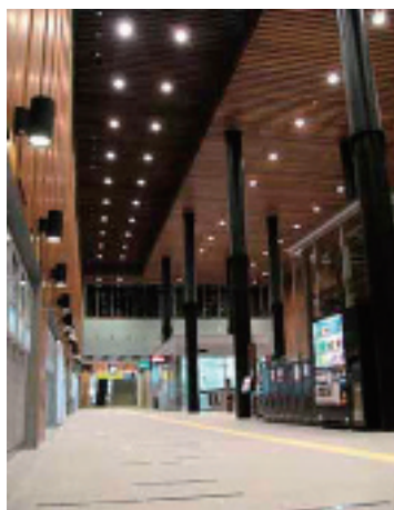
中之島線 なにわ橋駅コンコース
