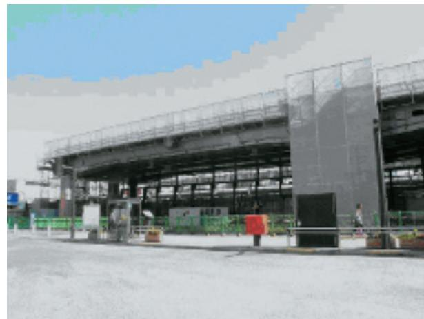
写真2 工事中の鋼ラーメン高架橋（平成21年6月）
