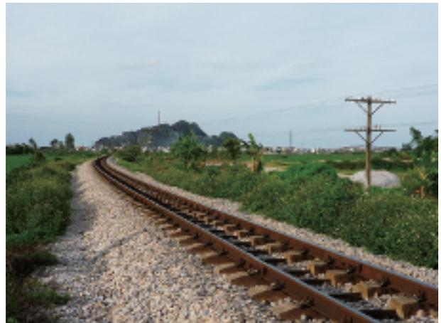
写真-21 ニンビン駅近くの線路状態。比較的良好な状態に保守されている。南北統一鉄道は単線・非電化である。(ハノイ方を見る。2008年8月14日)
