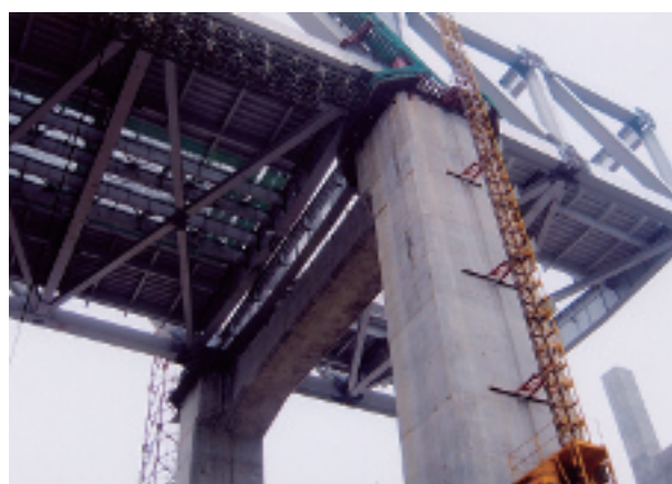
写真一3 建設工事の進む交通施設 (朝天門長江大橋)
