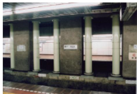
写真-3-7 耐震補強（トンネル内）
