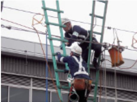
写真-4-3 架線補修作業
