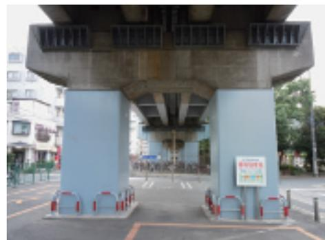
写真-3-6 耐震補強（高架橋）
