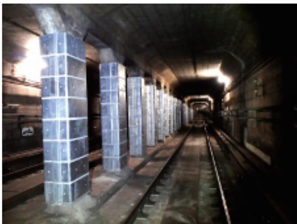
《さらなる耐震補強工事（中柱補強）》
