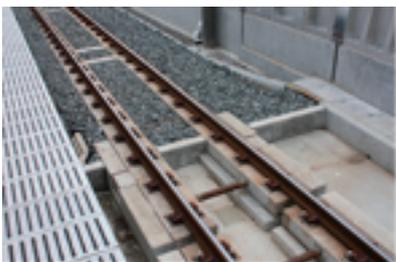
写真-3 ラダーマクラギ（バラスト・フローティング境界）
