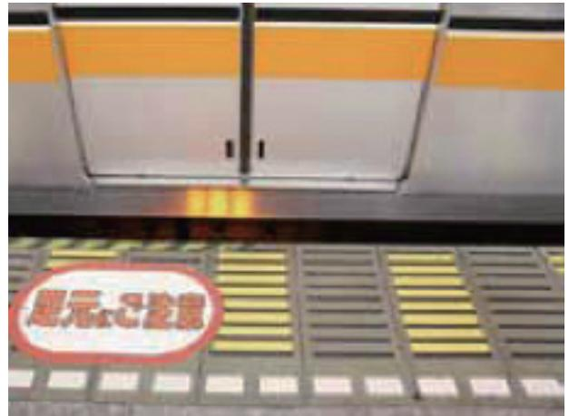
写真-1-6 転落防止警報装置
