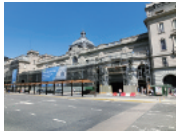
写真－6 外装の改修工事が行なわれているレティー口駅では、3路線の列車が発着する。(西を見る。2015年11月15日)
