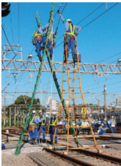
電気担当による架線断線復旧作業
