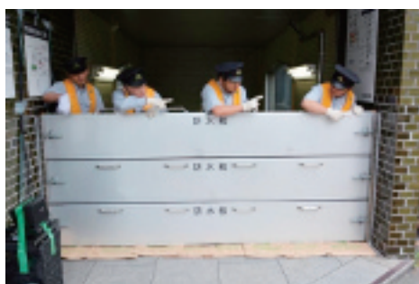
A1出入口に止水板を設置
