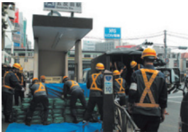
写真－3 集中豪雨による駅出入口からの浸水を想定した訓練（東京都交通局提供）
