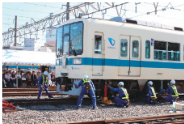
車両担当による脱線復旧作業
