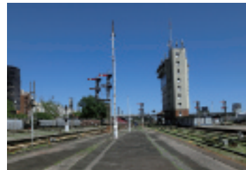
写真－12 レティーロ駅で使用されている腕木式信号機。(北西を見る。2015年11月15日)
