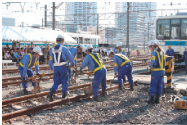
工務担当による軌道補修
