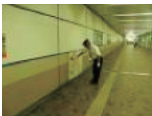
補助散水栓の巡視点検
