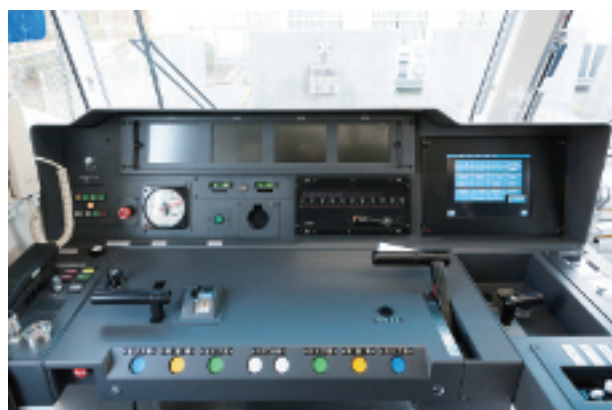
図-5 乗務員室運転台
