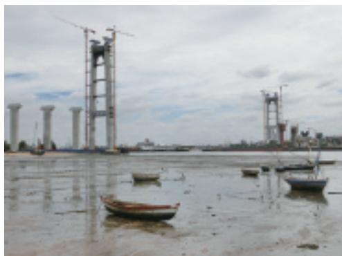
写真-9 建設中のカテンベ橋。マプト湾横断部分は中央径間680mの吊橋になっている。(北を見る。2017年2月25日)
