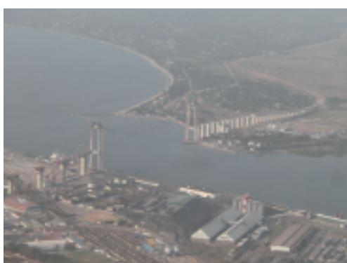
写真-10 建設中のカテンベ橋を飛行機（南アフリカ航空（SA）147便）から見る。手前がマプト中心部、向こう側がカテンベ地区。主塔が湾の両側に立ち、ケーブル工事が行なわれている。(南を見る。2017年6月16日)
