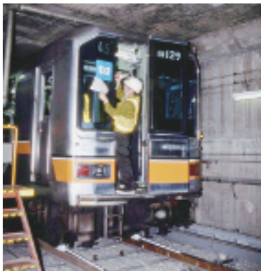
2004(平成16)年4月1日「ハートM」へ 隠していたシートを剥がす作業
