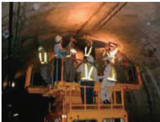
【トンネル打音調査】
