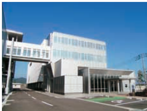
図2 管理棟と工場棟への連絡通路
