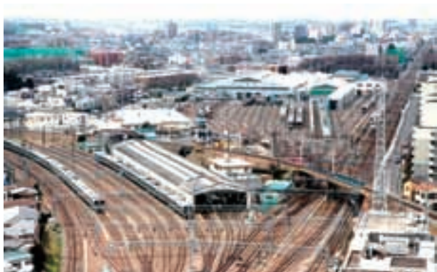
写真－2 大野総合車両所全景
