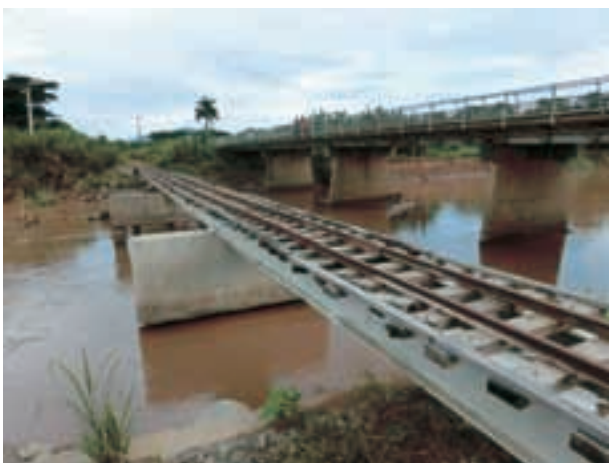
写真-11 2013年春のナワカ川の洪水で流され、その後突貫工事で復旧されたサトウキビ輸送鉄道の橋梁（手前）と右奥に見えるのは道路橋。(2014年2月22日)
