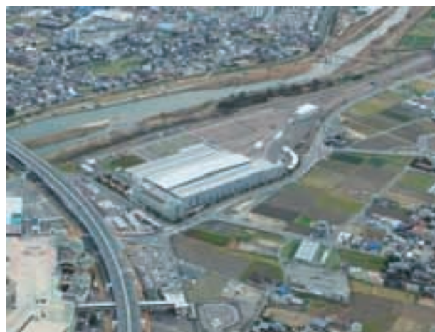
図1 橋本車両基地 航空写真
