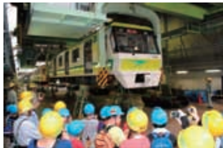
クレーンつり上げ作業
