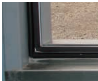
図2 枠に取り付けた2重のゴム
