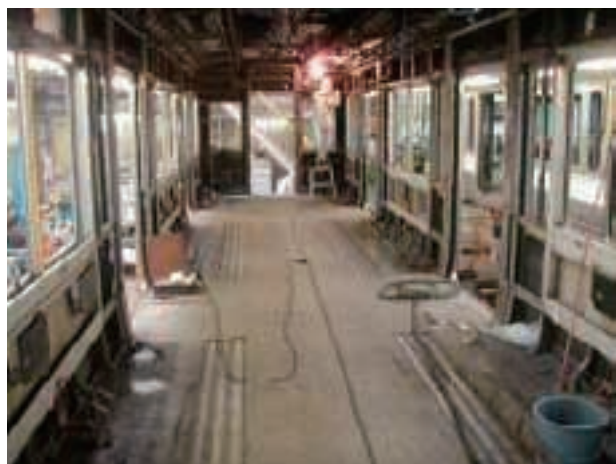
写真－5 内装取外し状態
