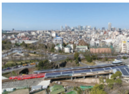
丸ノ内線四ツ谷駅太陽光パネル
