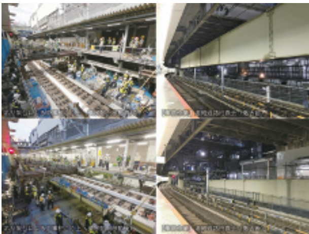
2020年5月29日夜間から6月1日早朝にかけ、埼京線を区間運休して進められたJR渋谷駅のホーム移設
