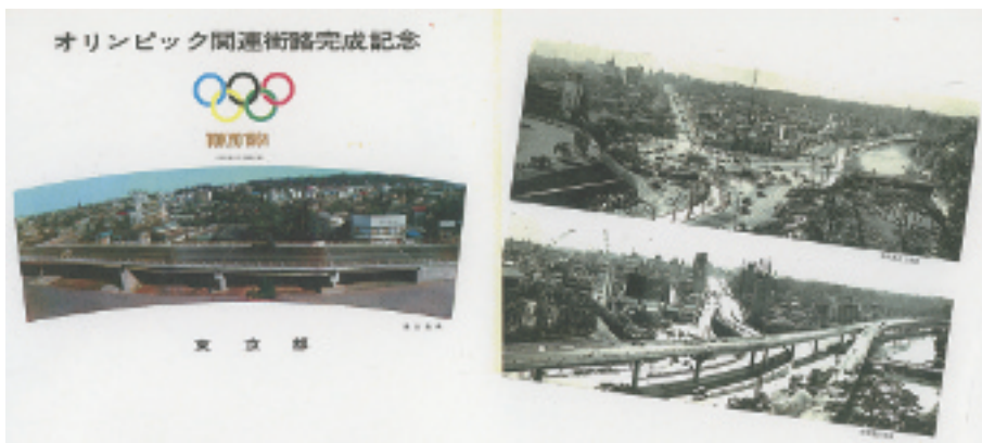
資料-20 オリンピック関連街路完成記念 オリンピック関連街路として都心の主な都道の整備を重点的に行った。赤坂見附付近の工事前と完成時の定点写真では立体交差が完成し、道路が拡幅されている。
