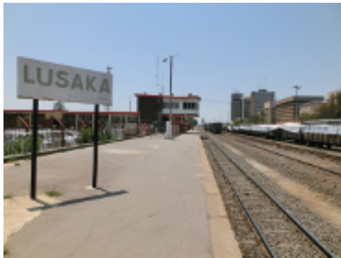
写真－8 ルサカ駅の駅名標には、標高1249.2mと書いてある（首都ルサカの標高は約1300m）。正面にある駅舎の2階で面談を行なった。（南を見る。2014年11月25日）
