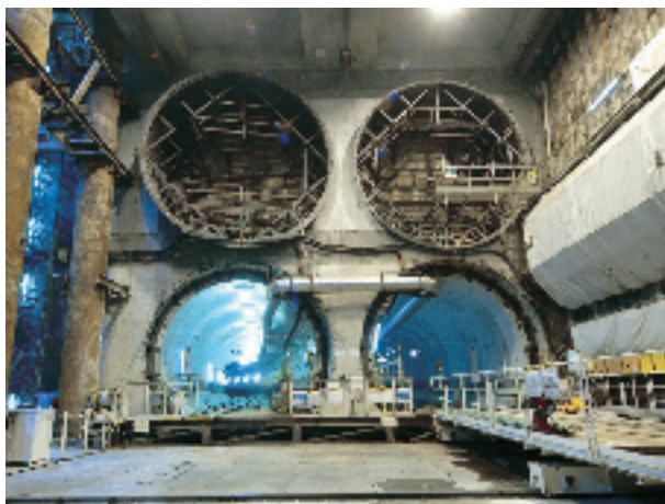
調布駅西側の立坑の様子
