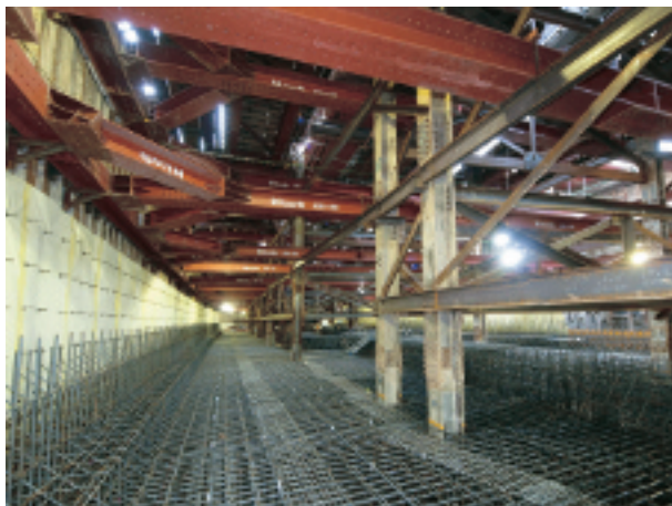
国領駅線路下の状況
