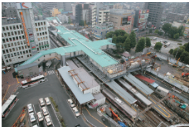
仮橋上駅舎化された調布駅
