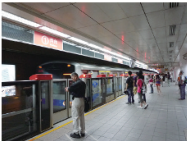
写真－3 MRT淡水線の台北駅に入線する電車。この駅には、開業後に可動式ホーム柵が取り付けられた。(2009年7月8日)
