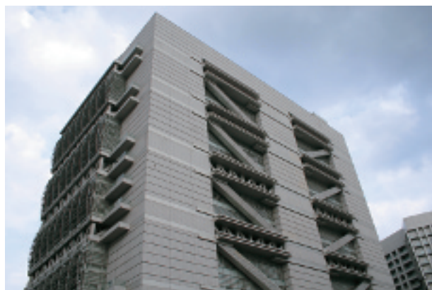
大阪府立国際会議場
