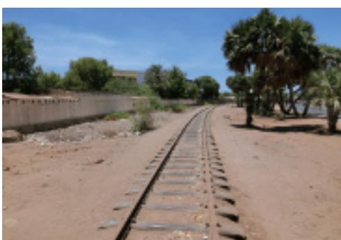
写真-41 ジブチ駅の少し南の幹線道路(右側)脇を走るジブチ=エチオピア鉄道の線路。鉄枕木を使用している。(北を見る。2015年4月22日)
