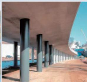
広瀬川橋りょう／RC箱型橋脚／橋長172m 西公園高架橋／RCスラブ式CFT柱ラーメン橋 橋長118m
