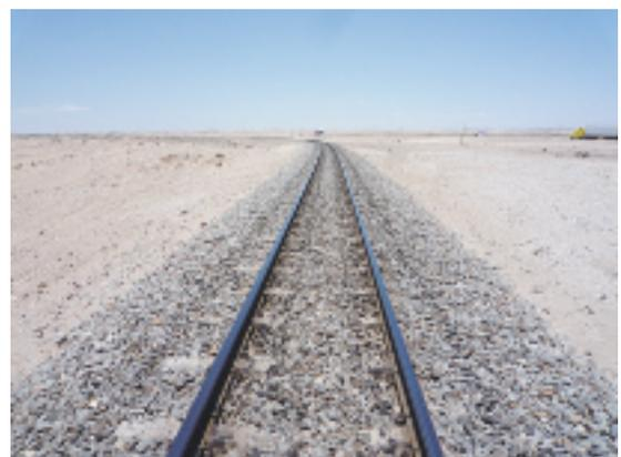
写真-52 砂漠の中に敷設された線路。バラスト軌道にコンクリート枕木・フィスト型締結装置を使用していて、よく整備されている。(2013年1月26日)
