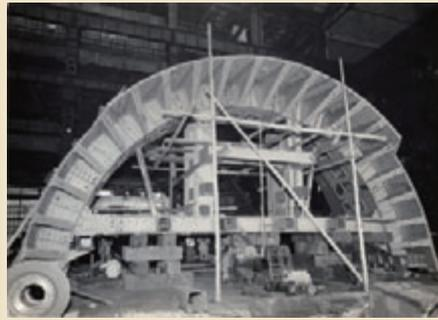
写真-2-1 丸ノ内線 ルーフシールド 機仮組立の様子
