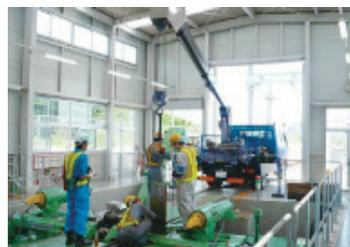
写真3 床下車輪旋盤の改修工事
