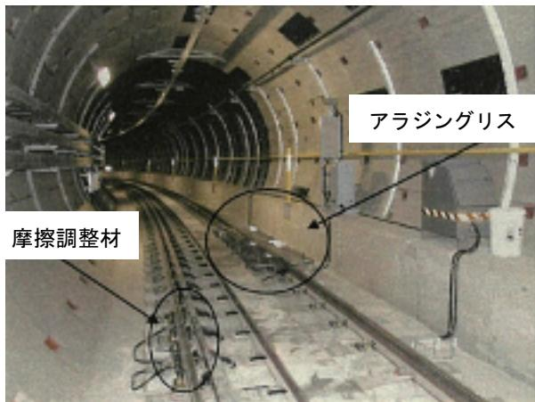
写真-2 軌道への摩擦調整材と塗油の設置
