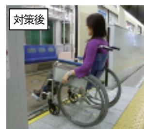
ついて調査した結果、コンクリート軌道・直線部においては、バラスト軌道・曲線部に比べて段差・隙間が小さいことを確認した。また、上記の駅を走行する車両の床面高さを調査した結果、車両の空溝差や車輪の摩耗等による変位量のバラツキは最大約5cmであった。
