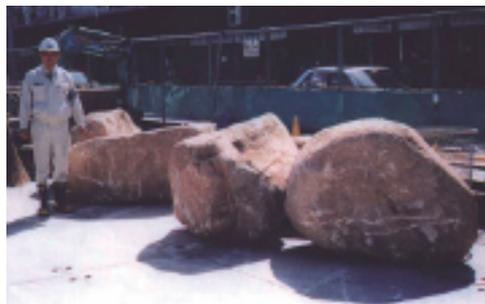
写真6 掘削した大きな玉石
