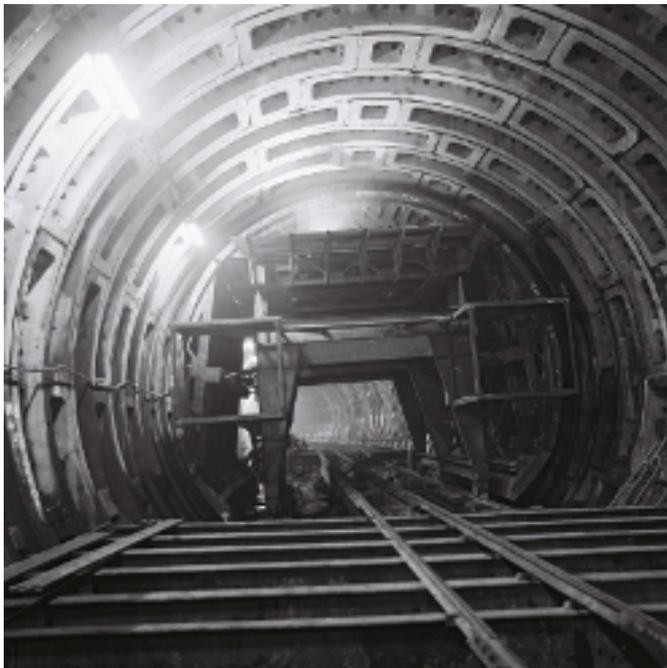
白山付近では、幅が狭く曲折している道路二路線を合わせることができないうえに地盤の起伏も激しかったため、複線大断面のシールド工法を採用した。
