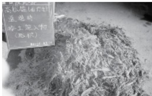
写真3-2 松杭をシールド機で切削
