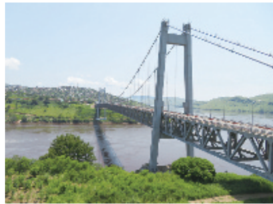
写真-6 全長が722mある鉄道・道路併用吊橋のマタディ橋。向こう側の丘には、40年前には人家はほとんどなかったが、現在はびっしりと立ち並んでいる。（右岸側から南を見る。2020年2月11日）
