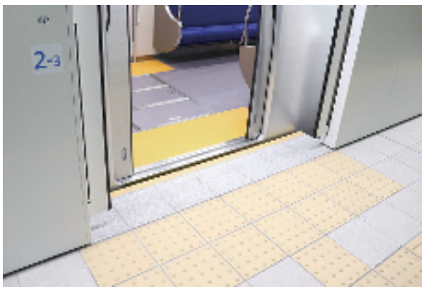
ホームとの段差・隙間
