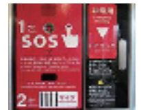
非常通報装置の設置例
