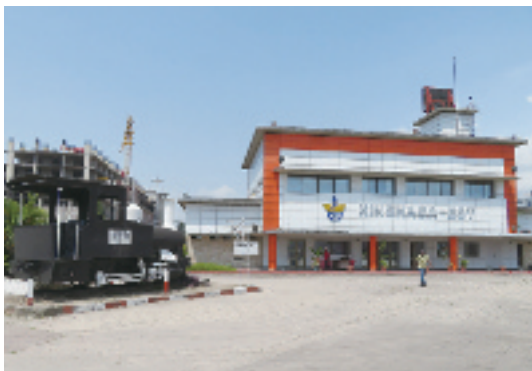
写真-3 キンシャサ東駅(マタディから365km)は、6月30日大通りの東端にある。左に見える保存蒸気機関車は1898年の鉄道開業時に使用されたものである。(北東を見る。2020年2月14日)
