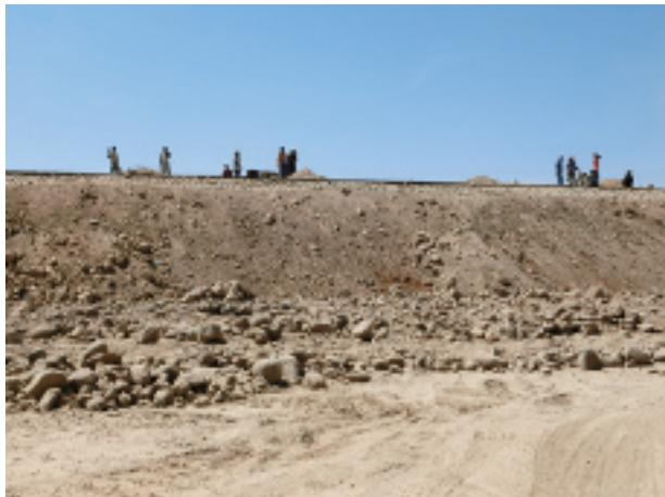
写真-28 ナガッド駅近くの盛土工事現場。高さが7mほどあり、その上で軌道工事を行なっている。(2015年4月22日)
