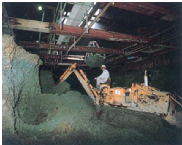
写真-10-4 開削工法
