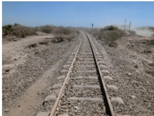
写真-35 運行を休止しているジブチ=エチオピア鉄道の線路。鉄枕木が使用されている。(2015年4月22日)
