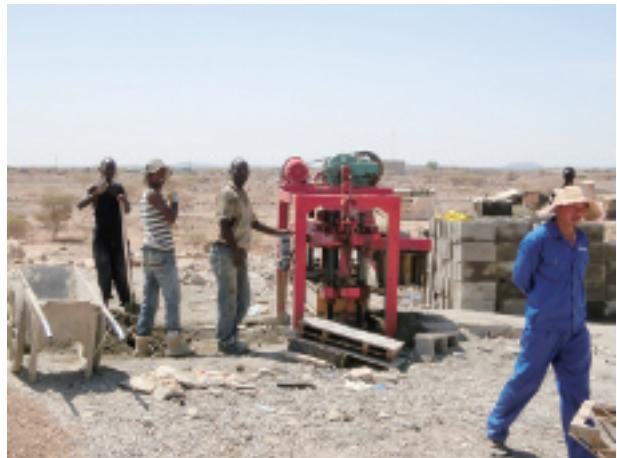
写真-31 ナガッド駅の工事現場では、建物用のコンクリートブロックを作っている。右端は工事監督をする中国人。(2015年4月22日)
