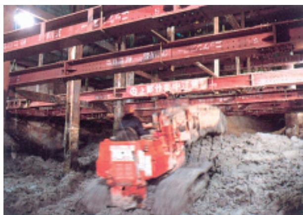
写真－9－2 開削工法
