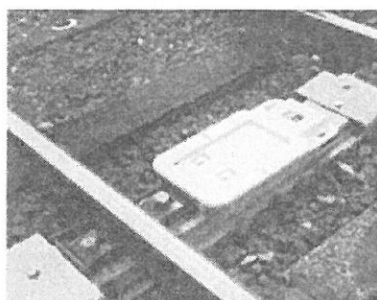
自動列車停止装置（ATS）の整備
