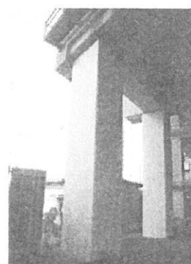
鋼板巻きによる高架橋の補強
