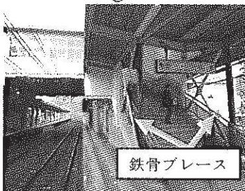
【橋上駅の補強】
