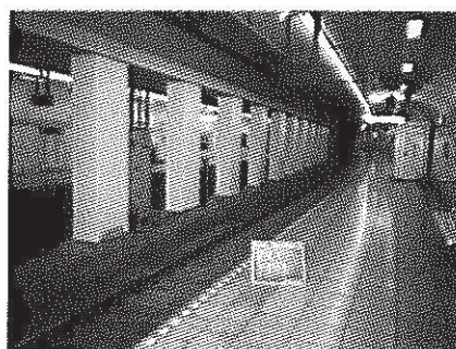
【地下鉄駅の中柱の補強】
