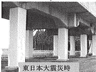
【高架橋の補強】
