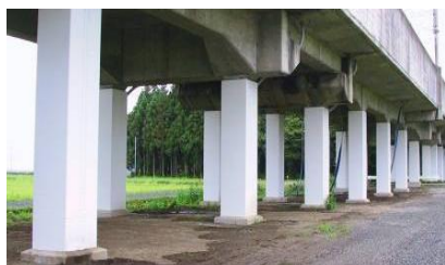
鋼板巻きによる高架橋の耐震対策
