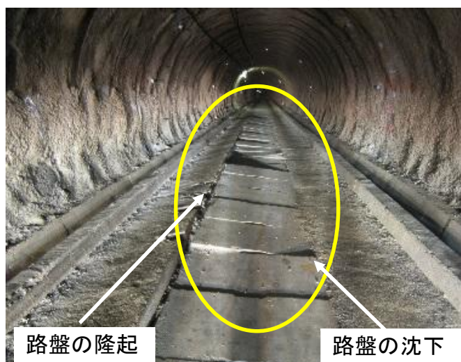
トンネル（先進導坑）の変状
