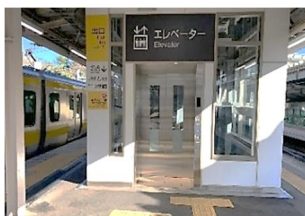
エレベーター
