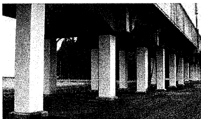
鋼板巻きによる高架橋の耐震対策
