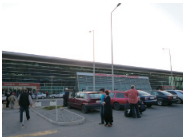
写真-3 トビリシ市内から東に約20kmのところにあるトビリシ国際空港。(2009年10月17日)
