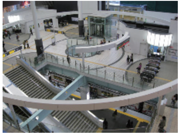
写真6 人工地盤に設けられた開口
