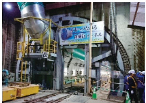
写真3 新横浜トンネル工事現場
