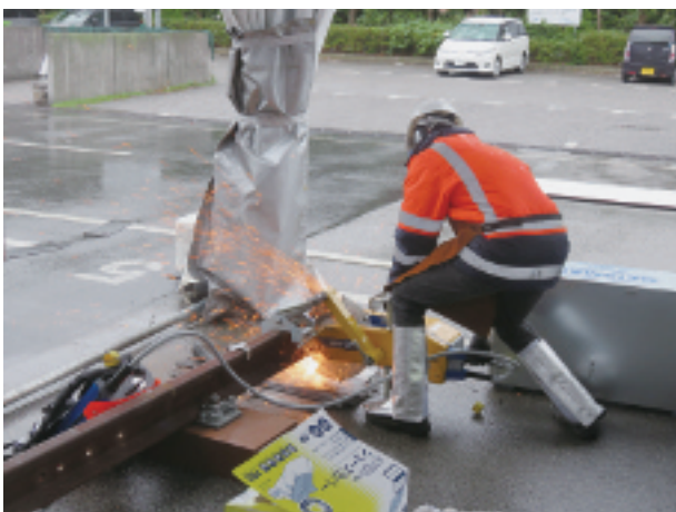
屋内展示がメインの鉄道技術展では珍しい屋外でのレール溶接の実演。
