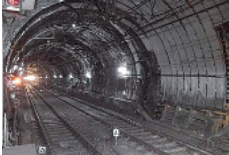
難波線のシールドトンネル
