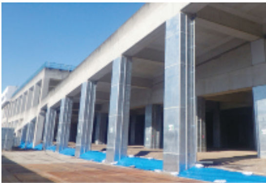
早期運行再開のための耐震補強工事
