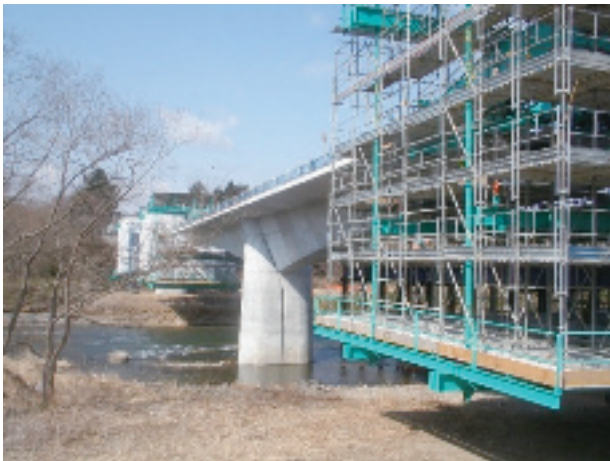
写真-2 広瀬川橋りょう
