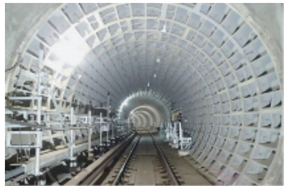
シールドトンネルの補修
