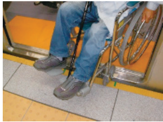
写真-9 ホームとの隙間
