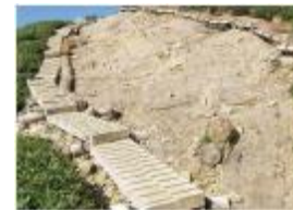
自然保護のための 遊歩道の整備
