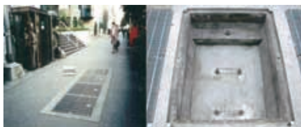
図-6 換気口と浸水防止機
