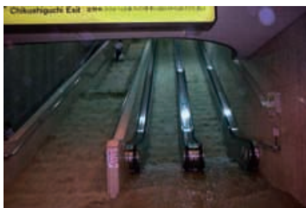
地下鉄博多駅に流れ込む濁流
