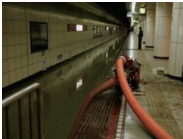
冠水した地下鉄博多駅ホーム
