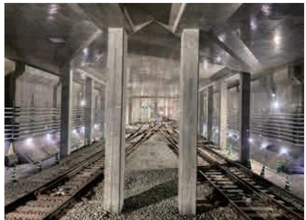
開削工法で建設された夢洲駅部のトンネル（前方が夢洲駅）。2本の柱が最近の地下鉄トンネルでは珍しいかもしれせん（画像・土木学会）
