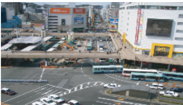
写真-4 「仙台駅工区」杭打ち・路面覆工状況 (JR仙台駅方から一番町方向を望む)
