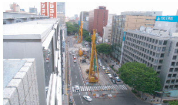
写真-3 「一番町工区」駅部杭打ち工事状況
