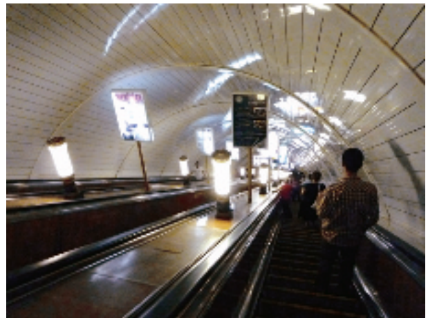
写真-6 バクー地下鉄には深い駅がある。これはサヒール駅のエスカレーター。（2009年6月14日）
