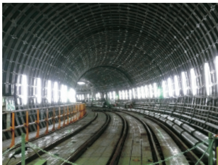
シールドトンネル
