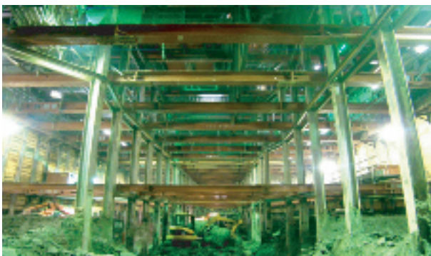
写真-5 「新寺工区」道路下約20m掘削状況
