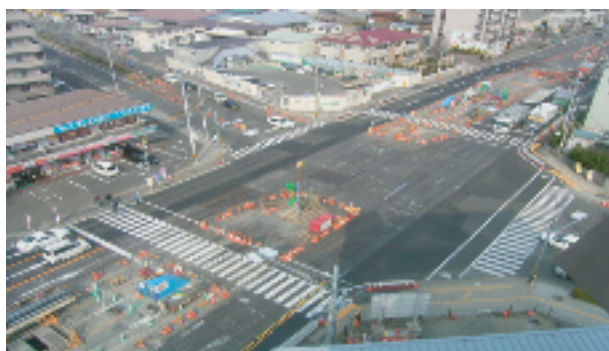
写真-7 「六丁の目工区」路面覆工状況
