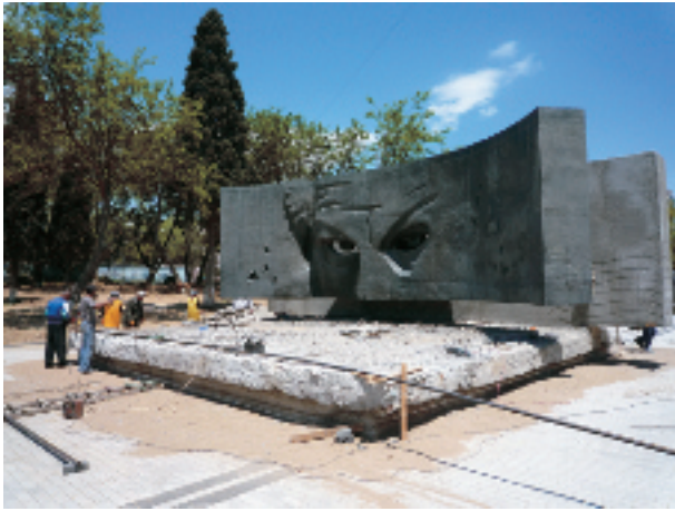
写真-5 バクーの都心にゾルゲ公園があり、ゾルゲの顔のモニュメントが設置されている。この日は、まだ改修工事が行なわれていた。(2009年5月30日)
