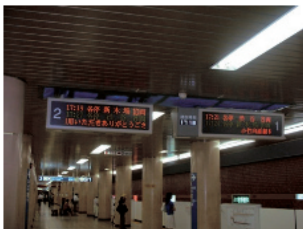
図3 自動旅客案内装置（3段化設置後）
