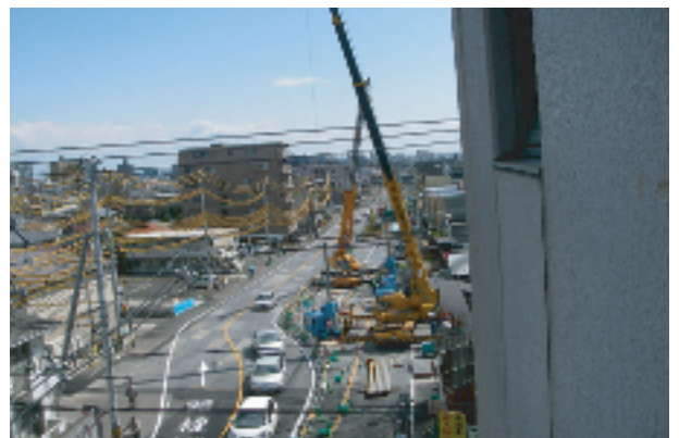
写真-6 「連坊工区」底盤改良(高圧攪拌工)
