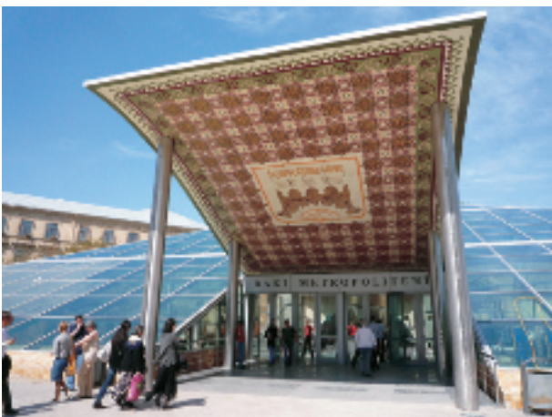
写真-12 旧市街のすぐ近くにあるイチェリ=シェヘル駅の出入口。大きな庇と三角形のガラス屋根が特徴である。（東を見る。2009年5月17日）
