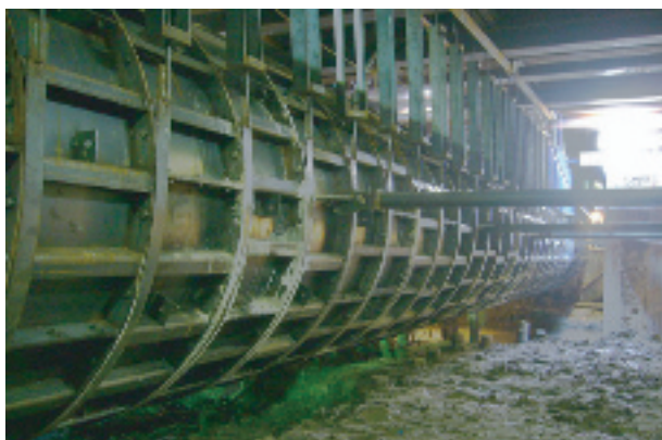
写真-8 「六丁の目工区」下水道幹線防護工状況
