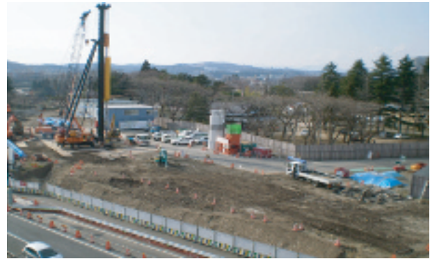
写真-2 「西公園工区」駅部杭打ち工事状況
