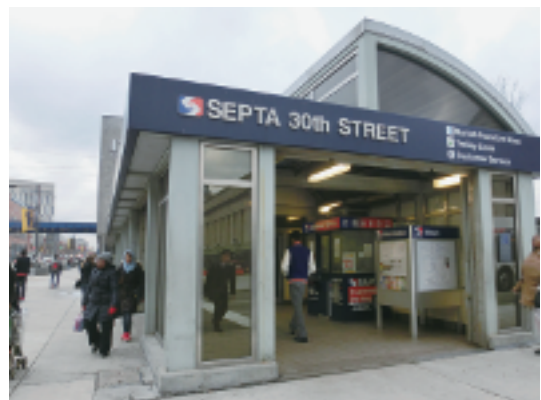
写真-13 SEPTAの30番通り駅。地下鉄東西線とトロリー (路面電車) の駅になっている。(2014年1月15日)
