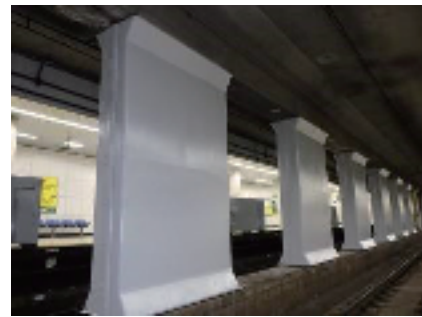
地下部中柱の補強
