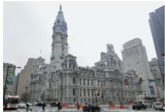
写真-6 フィラデルフィアの中心部にあるフィラデルフィア市庁舎は、レンガと白大理石・石灰岩で造られており、世界最大の独立石積み建造物である。左側の市庁舎正面をJFK大通りが走る。（南東を見る。2014年1月15日）
