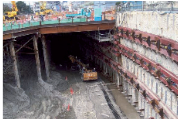
写真-3 徳重車庫掘削工事 (H19.4)
