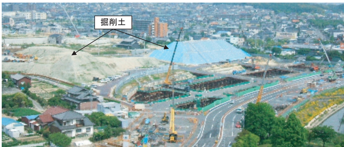
写真-4 徳重車庫工事全景 (H20.5)
