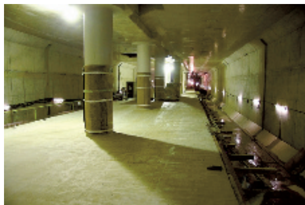
写真-1 開削工事（相生山駅 H21.10）
