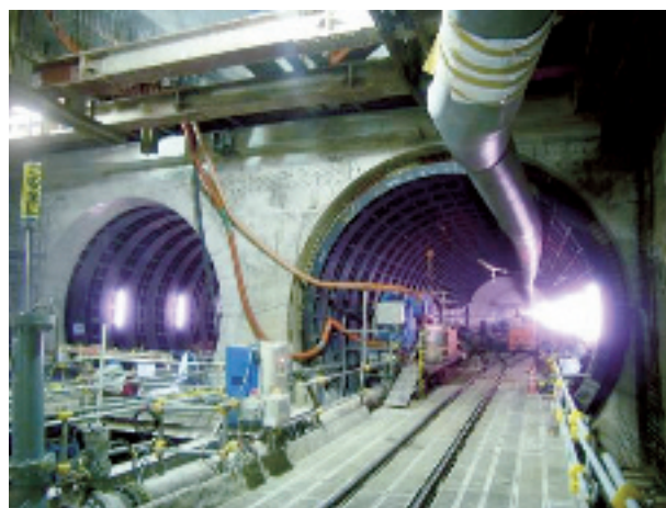
写真-2 シールド工事 (相生山駅～神沢駅 H21.12)
