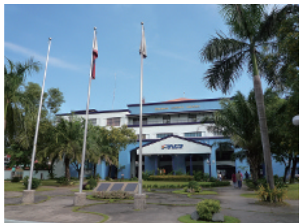
写真-6 PNRのトゥトゥバン駅。上層階にはPNRの事務所が入っている。(北を見る。2009年11月14日)
